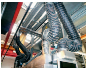
Absaugung von aggressiven chemischen Dämpfen bei der Herstellung von Klebefolien
