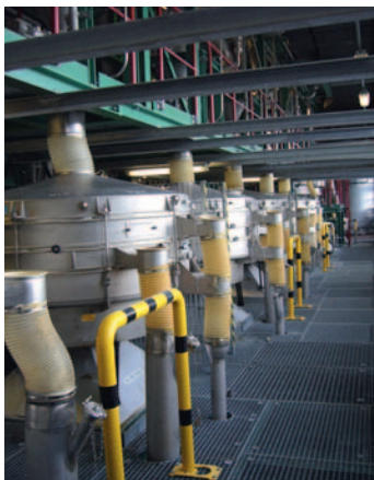
Erstellung von Verbindungen an Taumelsiebanlagen
