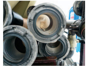
Verbindungsstücke zur Pellet-Anlieferung durch Silo-Fahrzeuge
