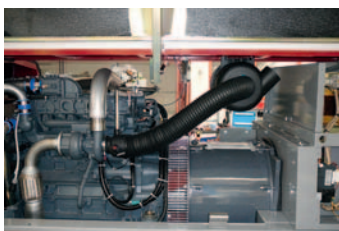
Luftzufuhr vom Luftfilter zum Motor
